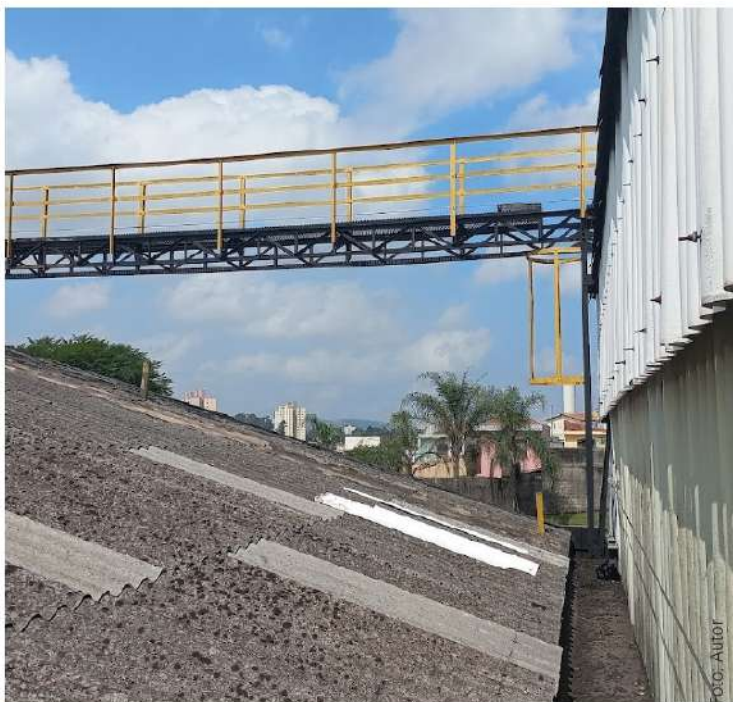
Figura 3 - Escada de fixa de acesso a calha menor que 5 metros
